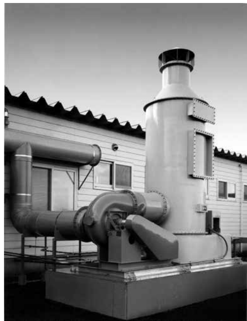
SRP 製スクラバー（排ガス洗浄装置）施工／設置例
