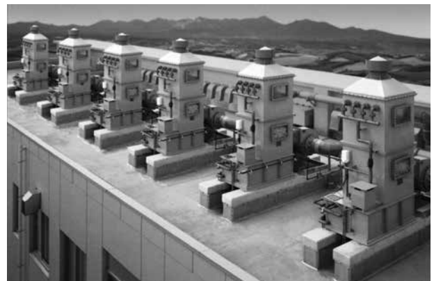
スクラバー（排ガス洗浄装置）設置例
