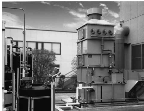
スクラバー（排ガス洗浄装置）施工／設置例
