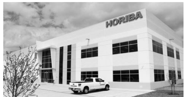
2017年4月、テキサス州ヒューストンに完成した新工場
