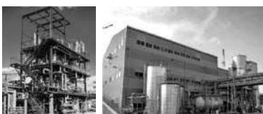
世界初の超臨界水ケミカルリサイクルプロセス（左）と超臨界水熱合成プロセス（右）
