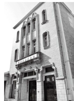
◀本社外観(昭和5年建設～現在に至る)
