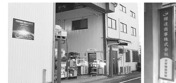
埼玉県東川口事業所倉庫
